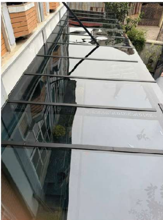
Công trình Ghi Xám VIN 006
